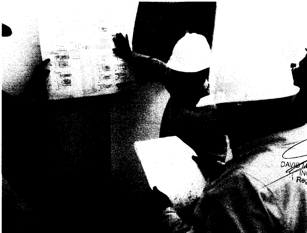
Fotografía N°06: Vista de inspección de trabajos eléctricos por parte de especialista de la supervisión.
