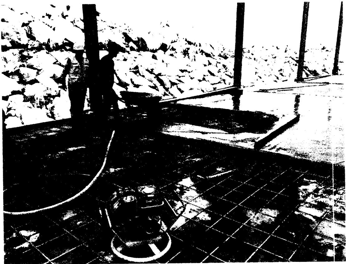
Fotografía N° 18: Vaciado de losa en muelle 2.
