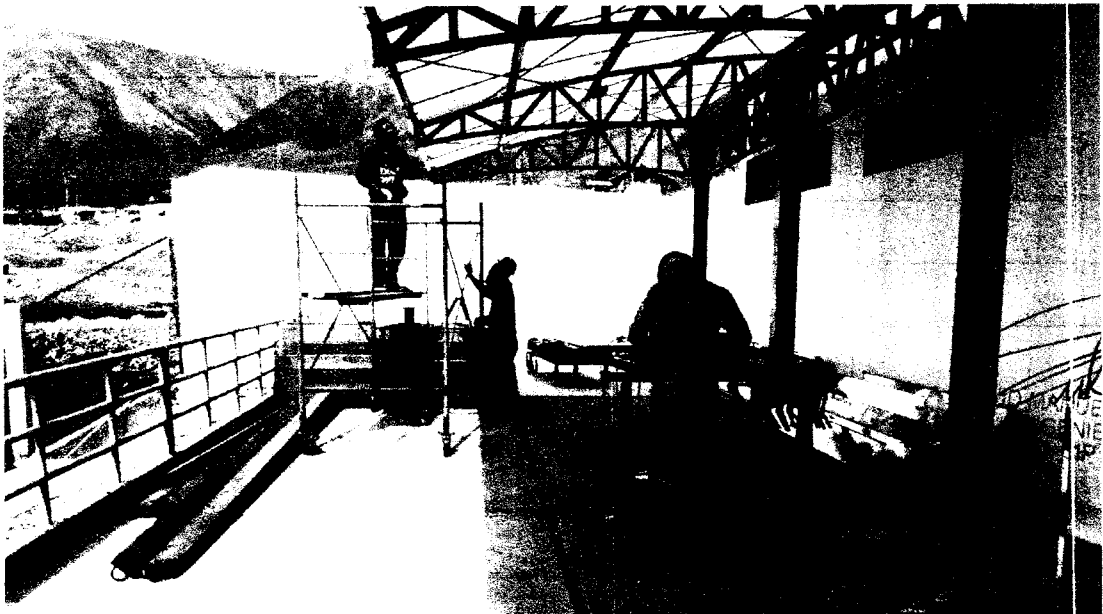
Fotografía N°12: Vista de instalación de canaletas para drenaje de aguas pluviales.
