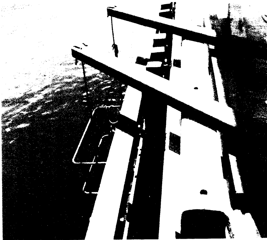
Fotografía N° 17: Vista de canastillas para instalación de defensas.
