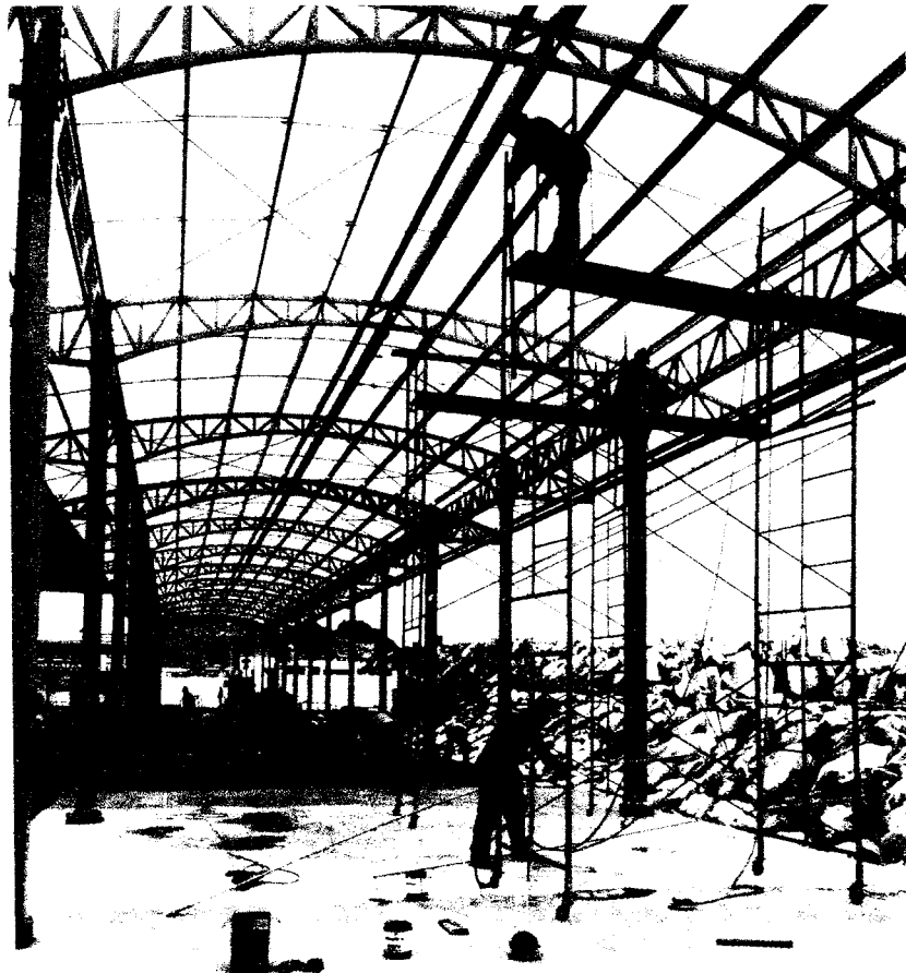
Fotografía N°21: Vista de instalación de policarbonato en estructura tipo 4.
